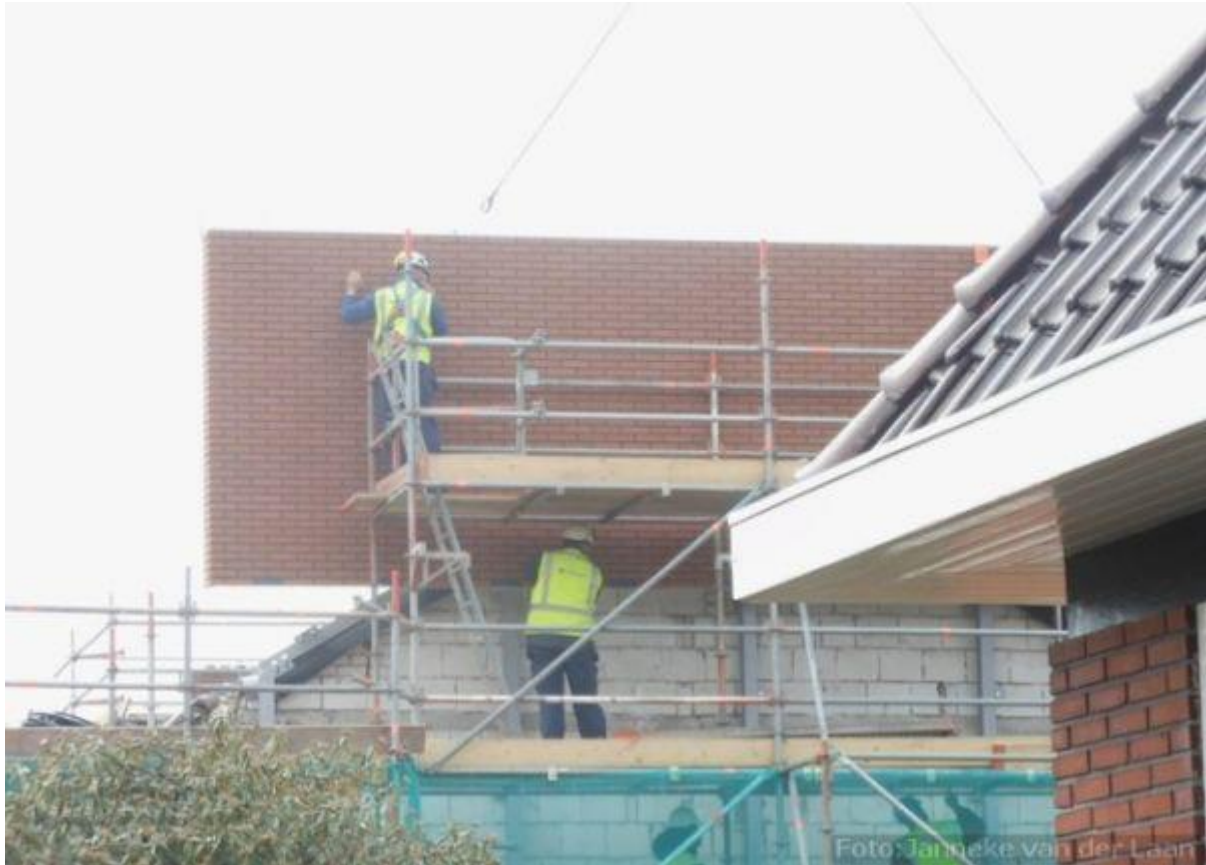
Foto: Woningverbetering aan de Korenlaan.
